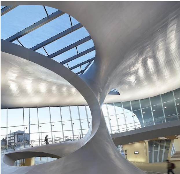
Strukturele elementen van station Arnhem Centraal. Beeld: UNS
